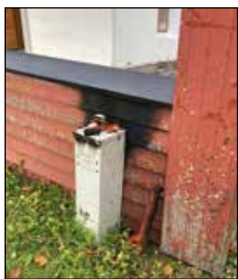
Branntilløp i inntaksskapet ved For kirke
